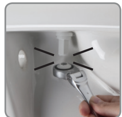
festziehen bis Unterteil abschert... „Bricht Sie - Sitzt Sie!“
